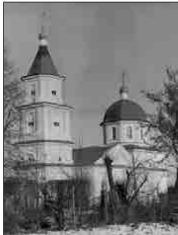
Церковь Преображения после ремонта в 1986 году
