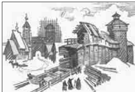
Строительство стен древнерусского города
